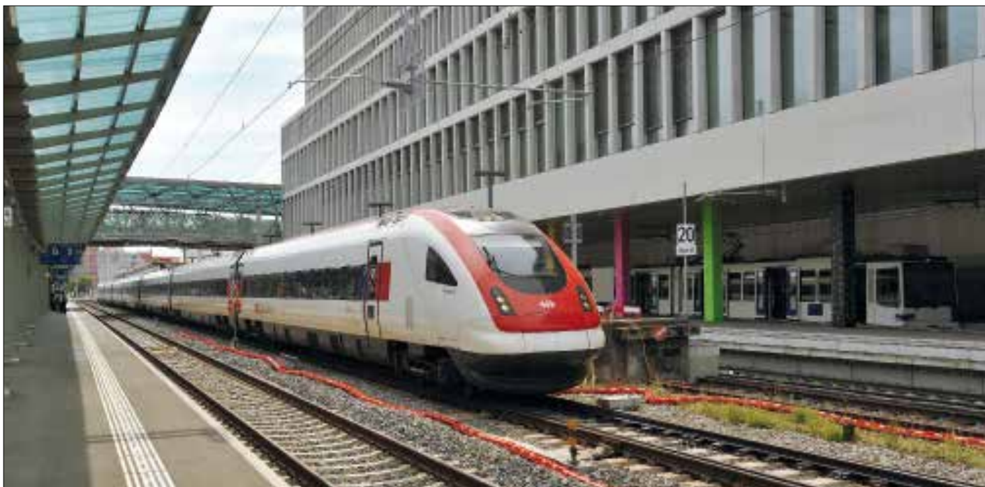
IC 5 Lausanne - Saint-Gall via Neuchâtel « brûle » la toute nouvelle et très moderne gare de Renens. À l'arrière-plan, le M 1 des tl permettant de desservir notamment le campus de Dorigny et de rejoindre Lausanne-Flon (août 2022).
